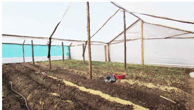
Gewächshaus in Renovierung
